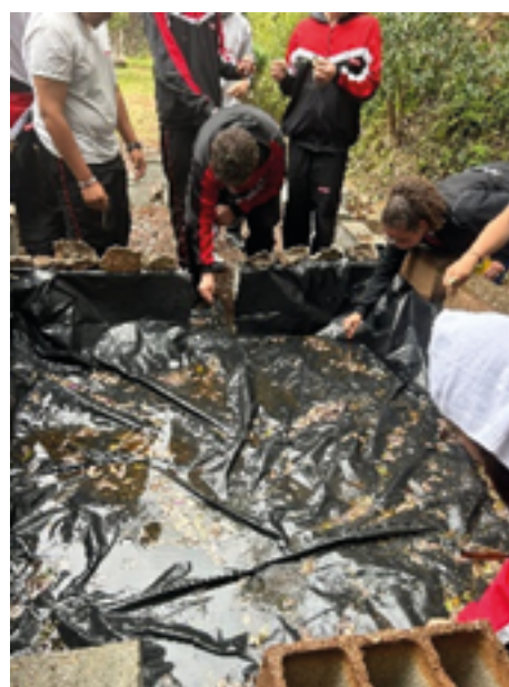
Figura 5: Processo de isolamento do solo na construção da composteira.
